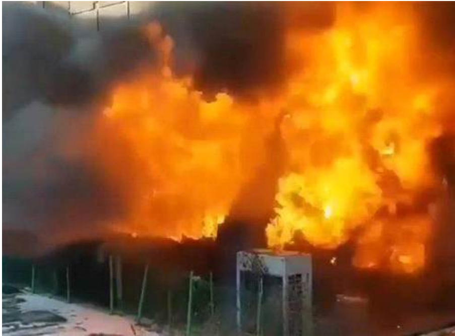
<그림 4.8> 필로티 구조 1층 주차장에서 분출된 화염에 의해 건물 외장재인 드라이비트가 연소되고 있음
