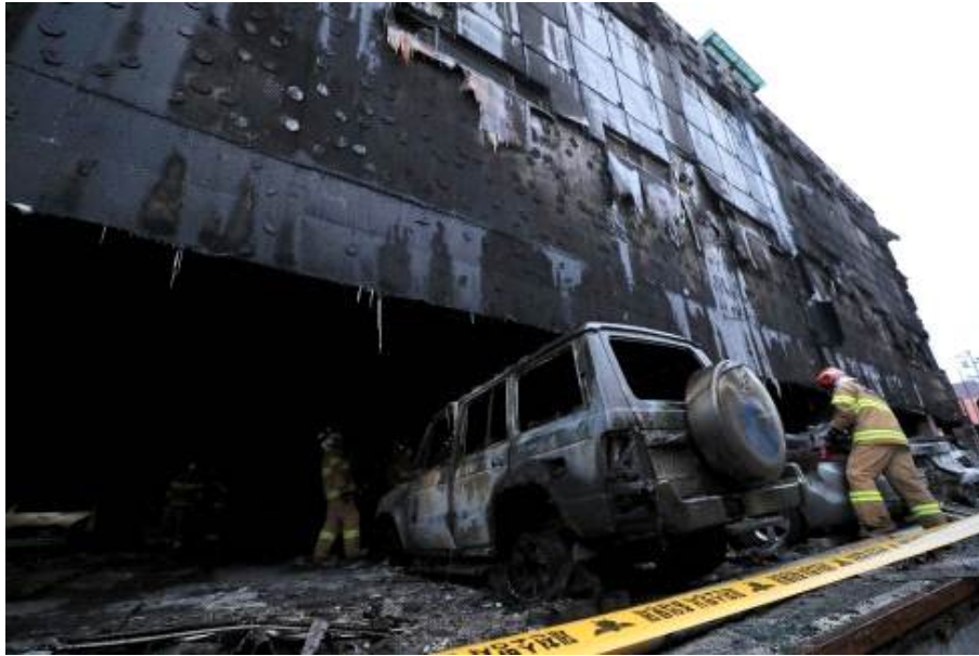
<그림 4.10> 1층 주차장에서 분출된 화염에 의해 연소된 드라이비트 외벽
