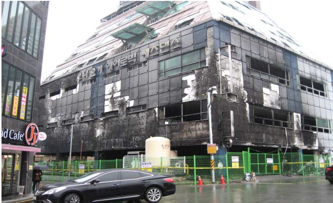
<그림 2.3> 스포츠센타 소훼상황 및 LPG 탱크
