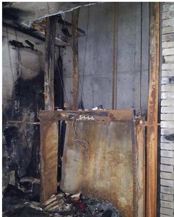
<그림 4.15> 덤웨이터 소화상황으로서 덤웨이터 샤프트를 통해 연소확대 되었음
