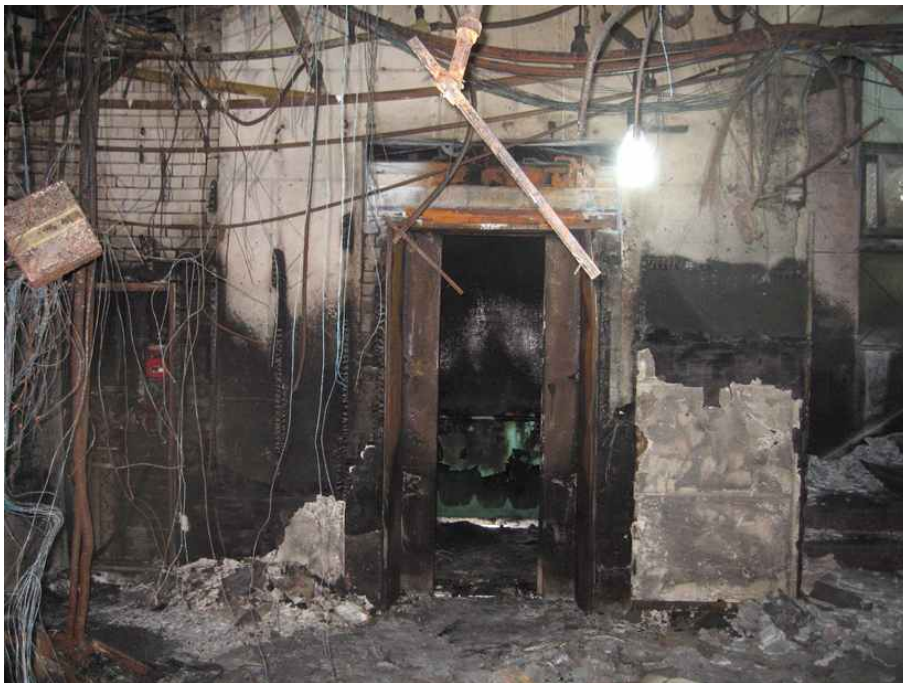
<그림 4.11> 1층 로비 내부 엘리베이터 소훼상황 사진 우측 방향에 중앙계단, 좌측 방향에 덤웨이터가 있음
