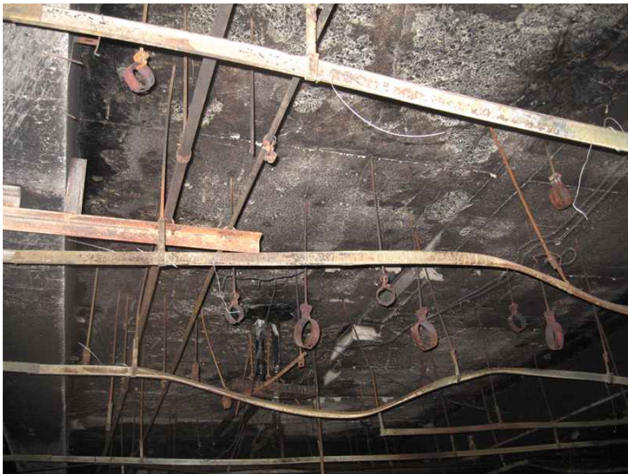
<그림 4.5> 천장 슬라브 소훼상황으로서 발화부로 판단됨
